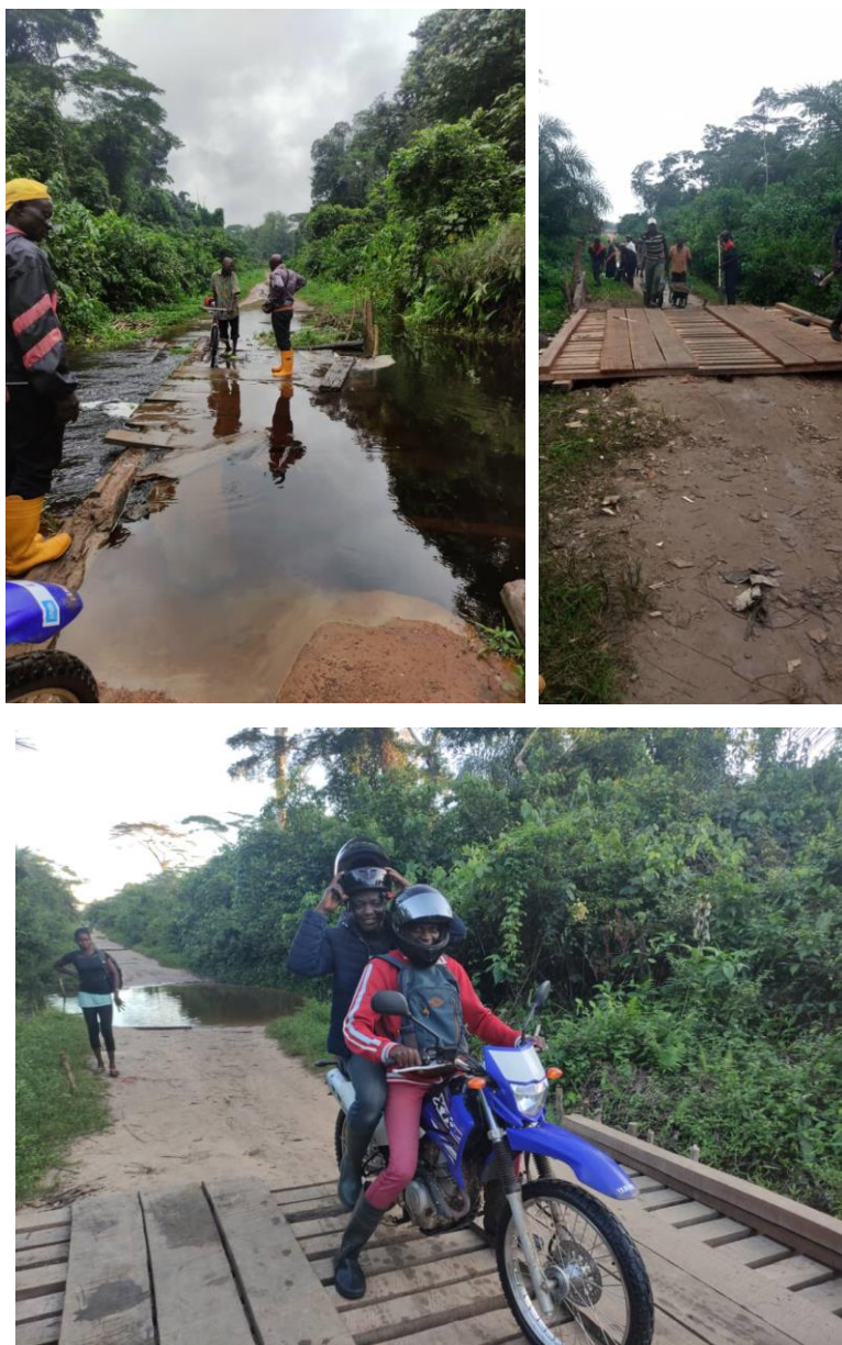
Links: Foto vóór de bouw van de Gbasambé-brug. Rechts: Foto tijdens de bouw van de Gbasambé-brug. Onder: Bezoek aan de brug door onze landencoördinator, Aloïs Kuma, zodra het bouwwerk voltooid was.
